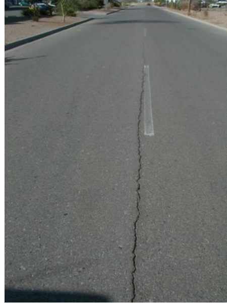
LONGITUDINAL CRACKING
